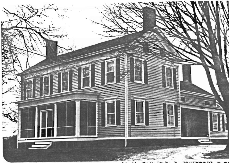
House (A); facing N.E.
