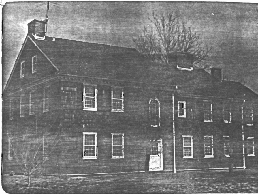
House (A); facing N.E.
